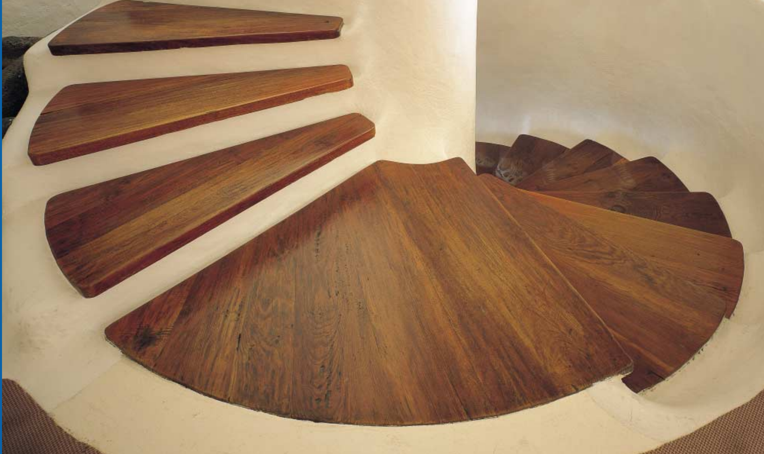
Mirador del Río. Detalle de escalera
