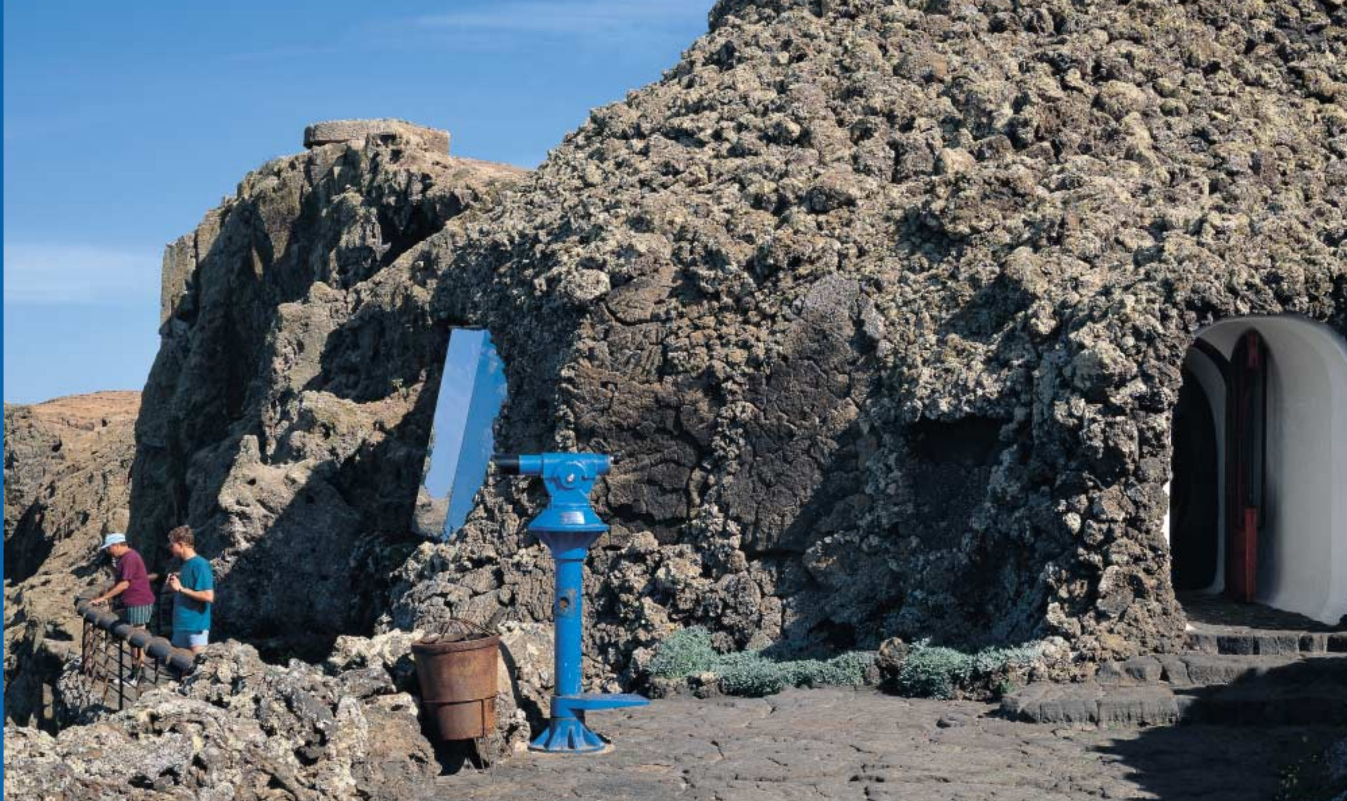
Mirador del Río. Fachada lateral y cubierta
